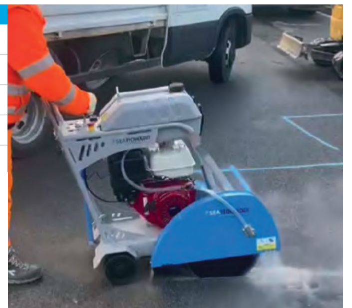
Taglio asfalto stradale con Seafloor 500 S
