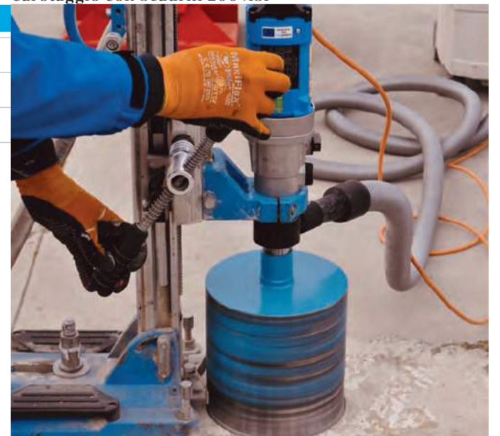
Carotaggio con Seadrill 200 ASP
